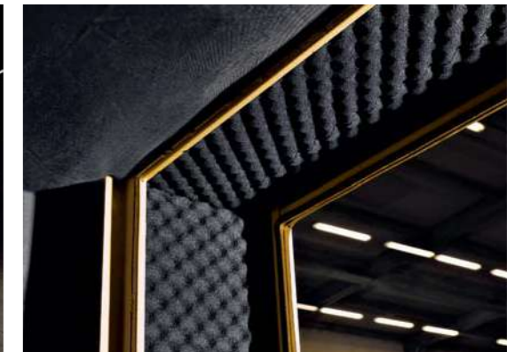
Dettaglio materiale insonorizzante Soundproofing material detail Détail matériel d'isolation
